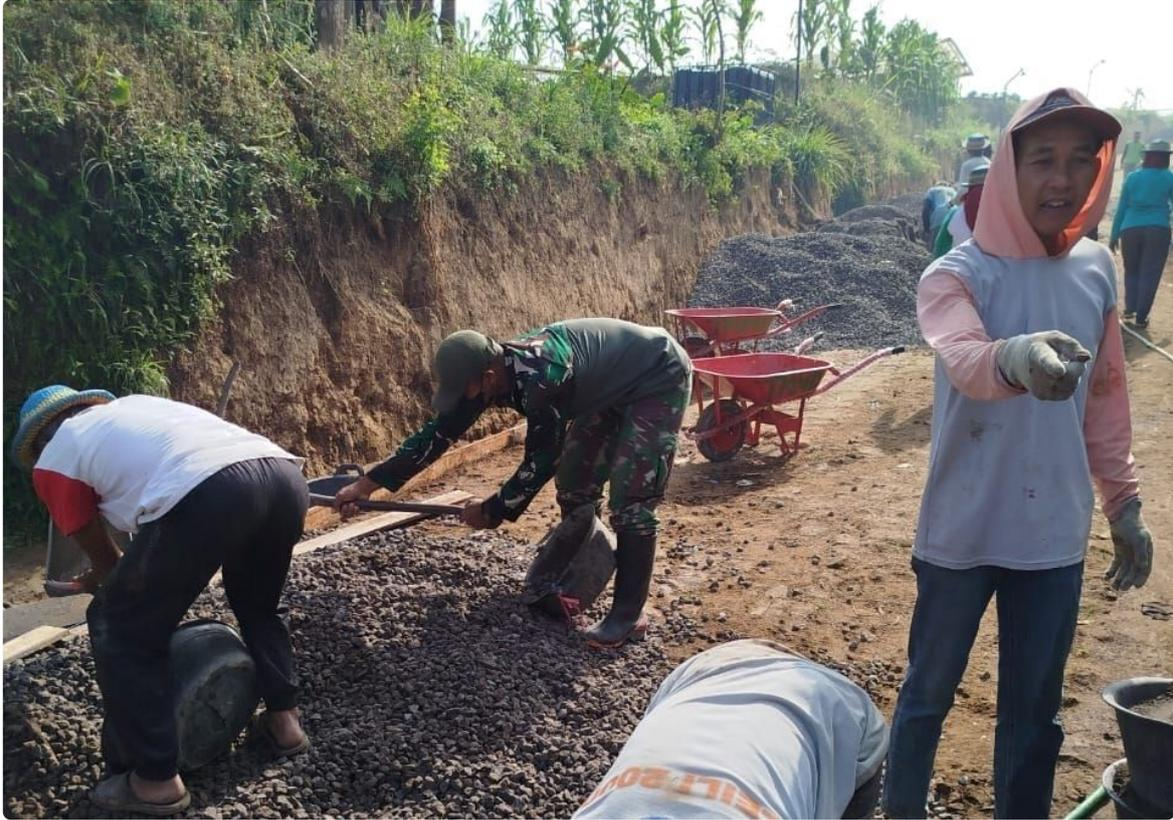
Dalam keterangannya Serda Makdam mengungkapkan, Karya Bhakti pengecoran jalan desa ini menghubungkan antara Dusun Sidan menuju Dusun Noyogaten. Adapun jalan yang di cor sepanjang 360 m, lebar 4 m dengan ketebalan 12 cm.
