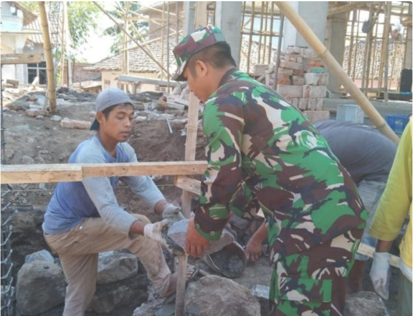
Serda Nasikin bantu pemasangan batu pondasi masjid
