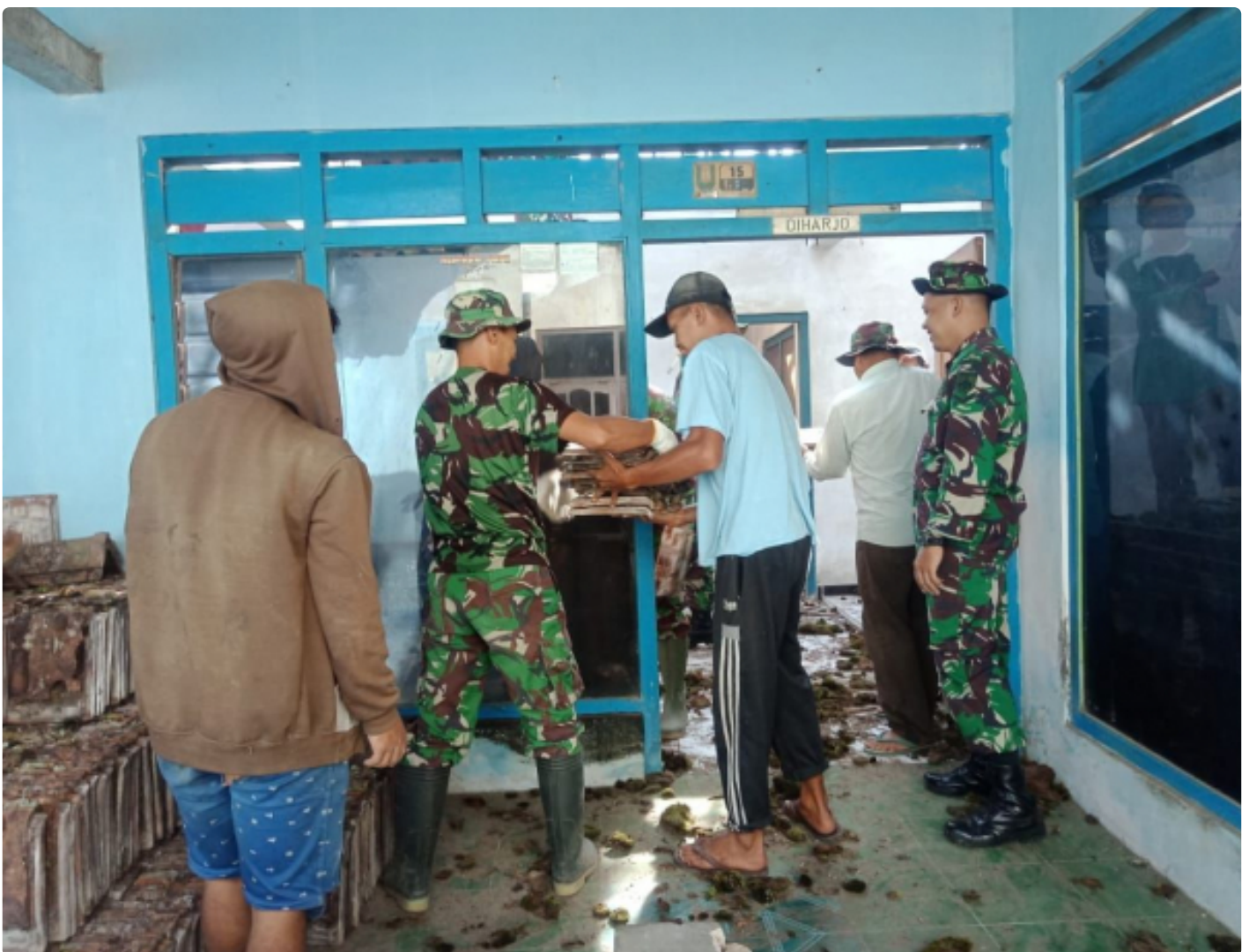
Danramil 12 Sawangan beserta anggota Bantu Pembersihan Material Genteng Akibat Puting Beliung
