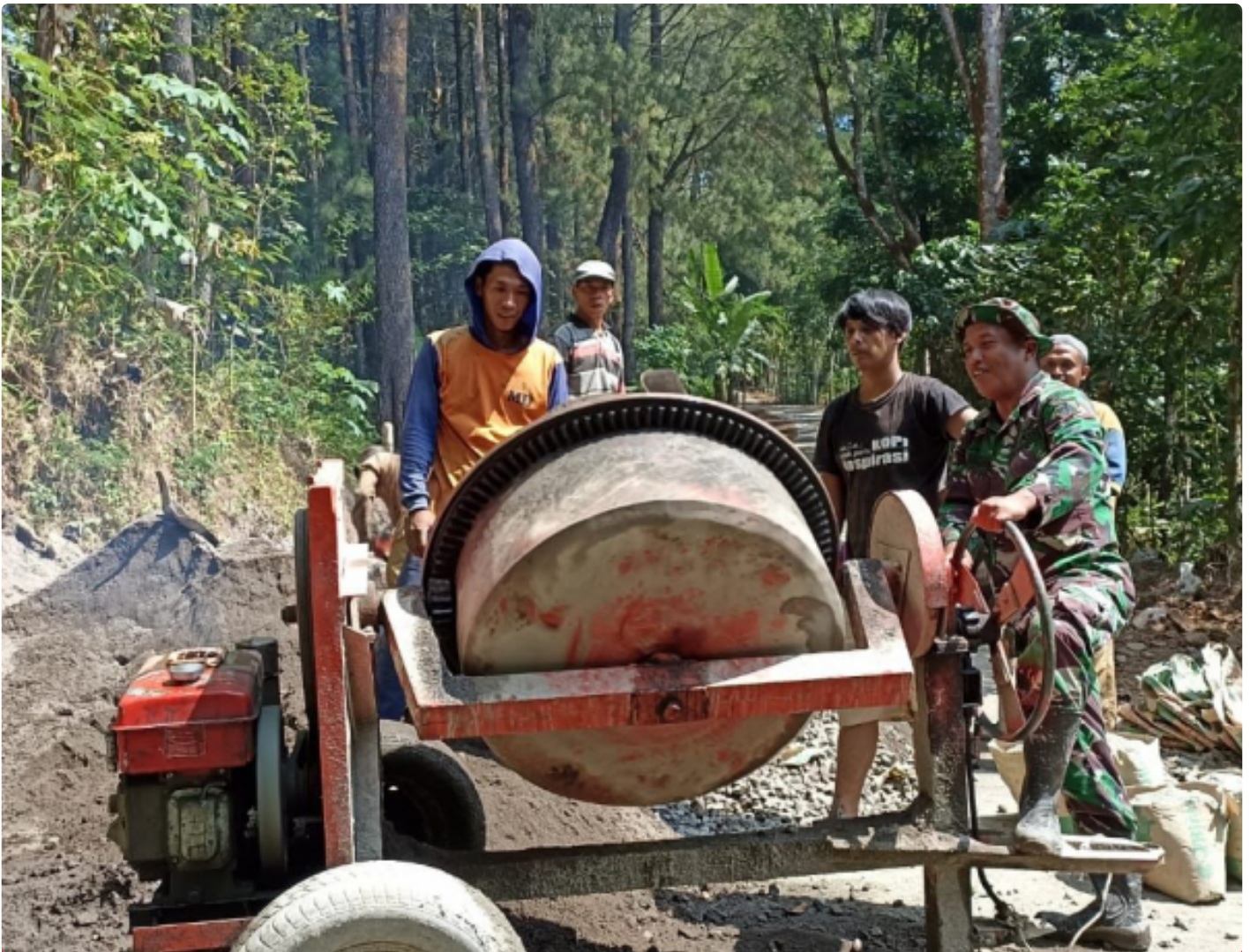
Satgas TMMD kebut pengecoran jalan
